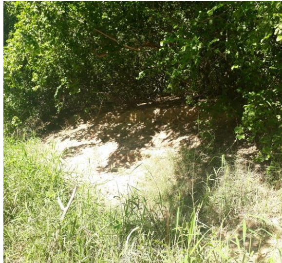
Figura 6: Foco Erosivo 2 (outro ângulo).
